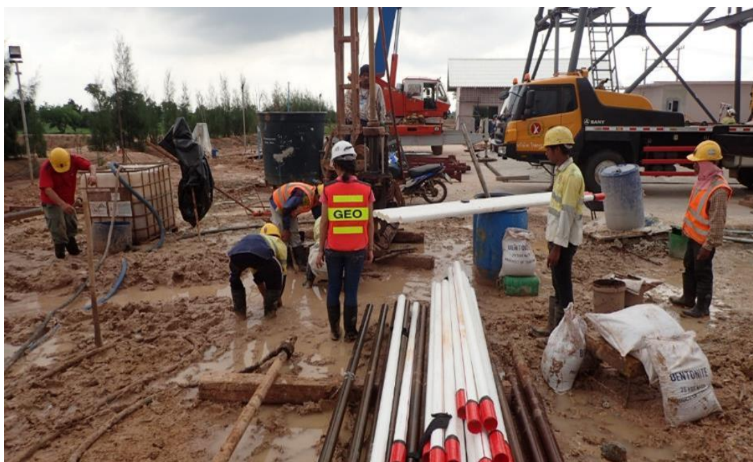
รูปที่ 3.7-10 การขุดเจาะและติดตั้งท่อรางในแนวตั้งสำหรับวัดการเคลื่อนตัวของมวลดินในแนวราบ
