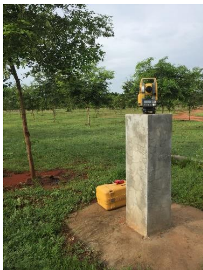
รูปที่ 3.7-2 การก่อสร้างหมุดหลักฐานอ้างอิง (Benchmark Point) และหมุดตรวจสอบบริเวณแนว การก่อสร้างขุดเจาะอุโมงค์แนวลาด
